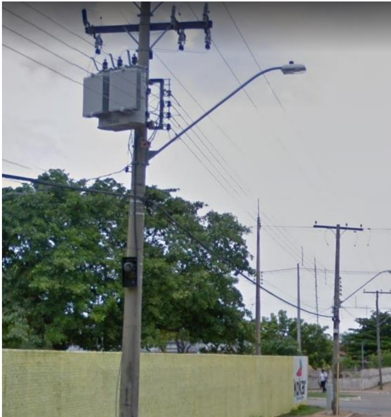
Figura 8-1 - Braço de Iluminação Pública para poste com transformador
